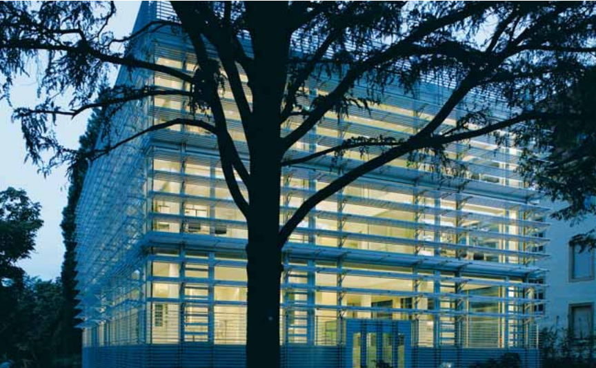
La fachada KNX-EIB puede ser construida e iluminada de distintas formas
