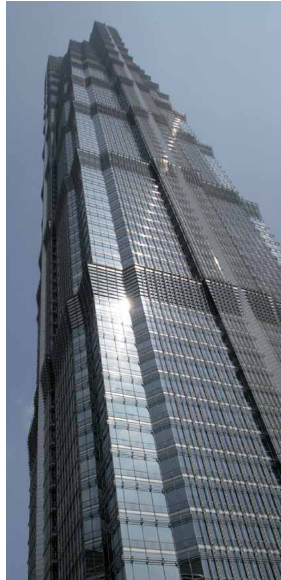
Control de todo tipo de edificios
