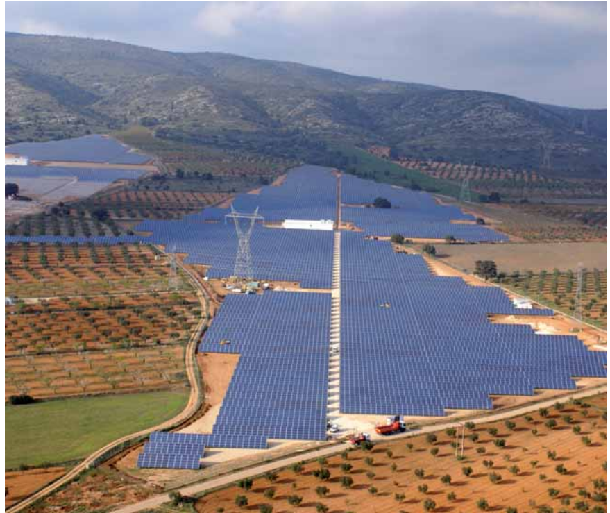
Planta fotovoltaica Beneixama 20 MW (España)
