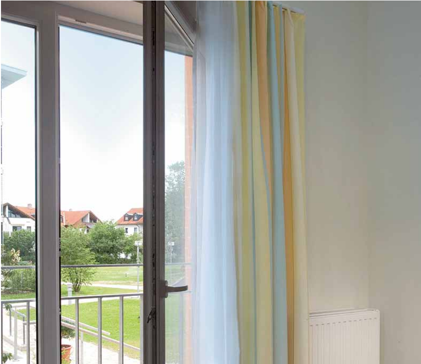
La calefacción se apagará o se conectará automáticamente, si un residente abriera o cerrara una ventana
